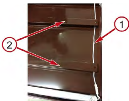
Sl. 10: Kabelski kanal LED-stolpca – priključni kabel (1), pritrdilna letev (2)
